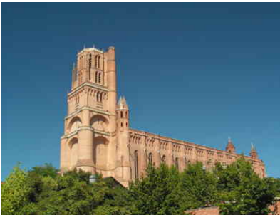
Gesamtansicht von S
