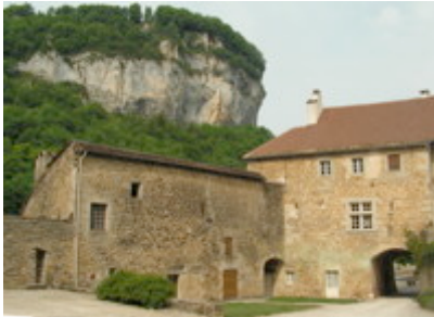
Abtei Baume-les-Messieurs Eingang
