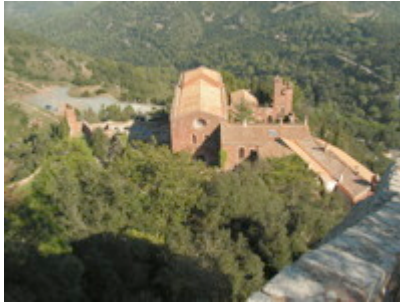
Blick auf die Anlage von der Ermita Santa Bàrbara aus
