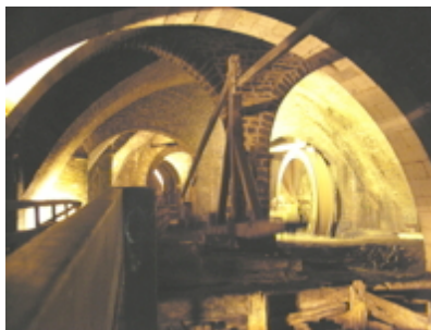
Unterirdische Anlagen: Pumpenantrieb: vorn Übertragungsgestänge hinten Wasserrad
