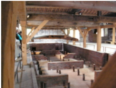
Blick in Heizraum unter Pfanne
